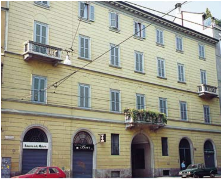
The Milan offices of the Egidio & Pio Gavazzi company, at n. 48, Corso Magenta.
